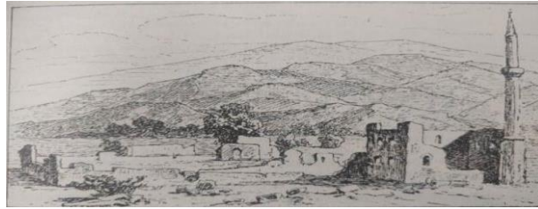
Resim 2. Nişka Banya'da yıkılmış olan camii 7
