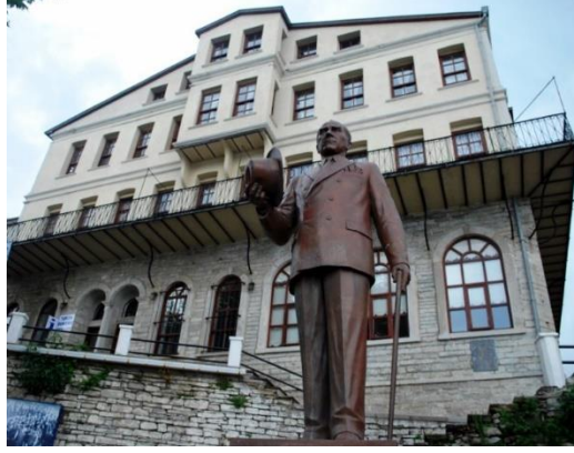
Resim 1: Tescilli İnebolu Türk Ocağı Binası (URL-4)
